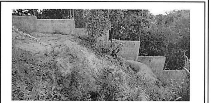
FOTO 6: SE VENCÍO EL MURO DE CONTENCIÓN QUE FORMABA PARTE DEL PATIO DE JUEGO PARA LOS ALUMNOS, DEJANDO UN PELIGRO EN EL PASO POR EL LUGAR, APARTE DE ESTAR SOCABÁNDOSE.
