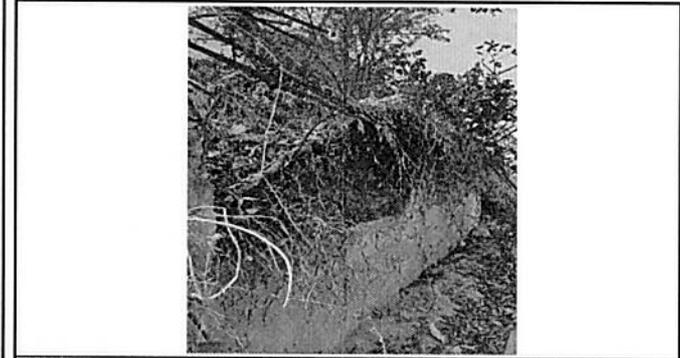
FOTO 3: REPARAR MURO DE CONTENCIÓN QUE SE CAYÓ
