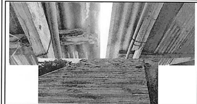
FOTO 1: CAMBIAR LÁMINA QUE CUMPLIÓ SU VIDA UTIL Y ESTRUCTURA DE MADERA
